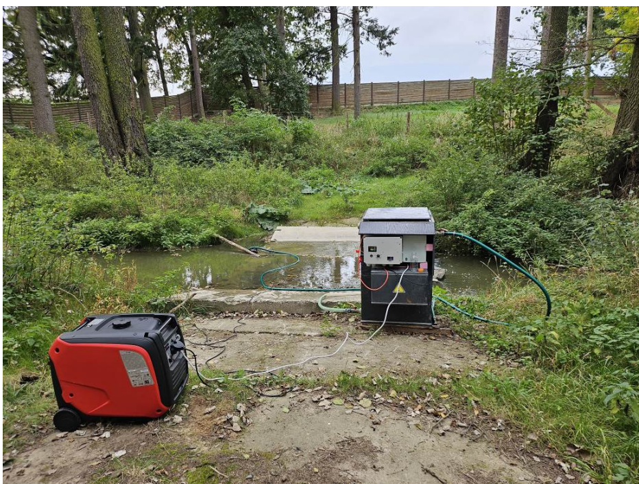
Obr. 7 Elektrokoagulační jednotka osazená na Dobřešovickém potoce na přítoku do Průhonického parku
