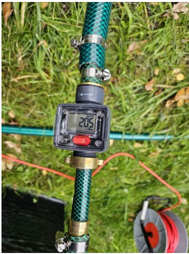
Obr. 8 Průtokoměr na přívodní hadici
